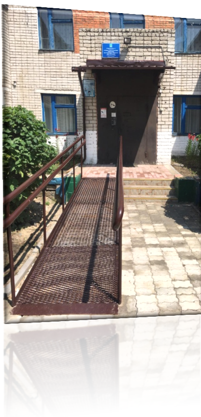
Ремонт центрального крыльца, устройство козырька, установка наружного пандуса, обустройство путей следования к зданию в МАДОУ ДС №54.
